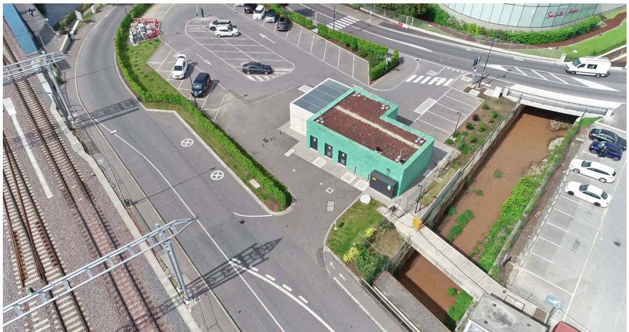
Vue aérienne sur le bassin d'orage « Ettelbruck Gare »
