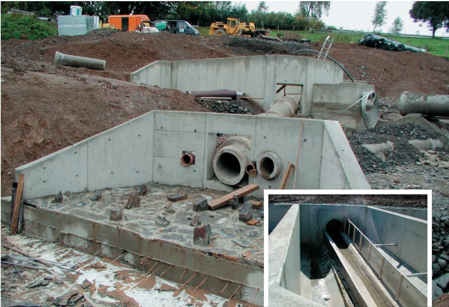
*Travaux de finition de l'ouvrage d'entrée au bassin tampon
