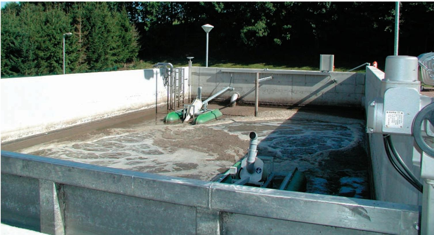
*Bassin d'orage équipé entre autres d'aérateurs afin d'assurer le rôle de station d'épuration intérimaire (août 2002)*
