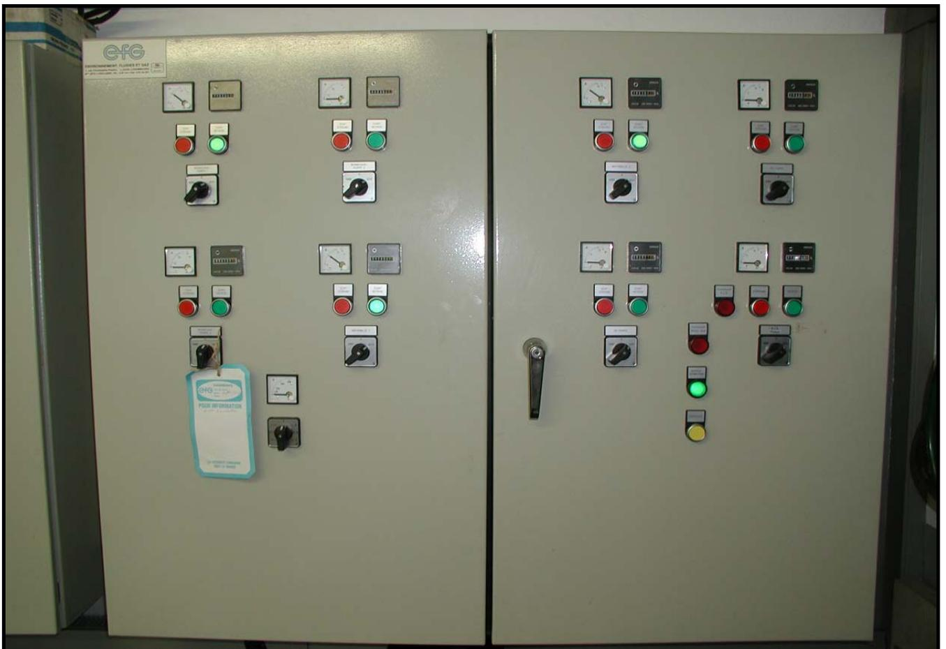
Tableau avec automate de commande et de télésurveillance de la station de Bissen
