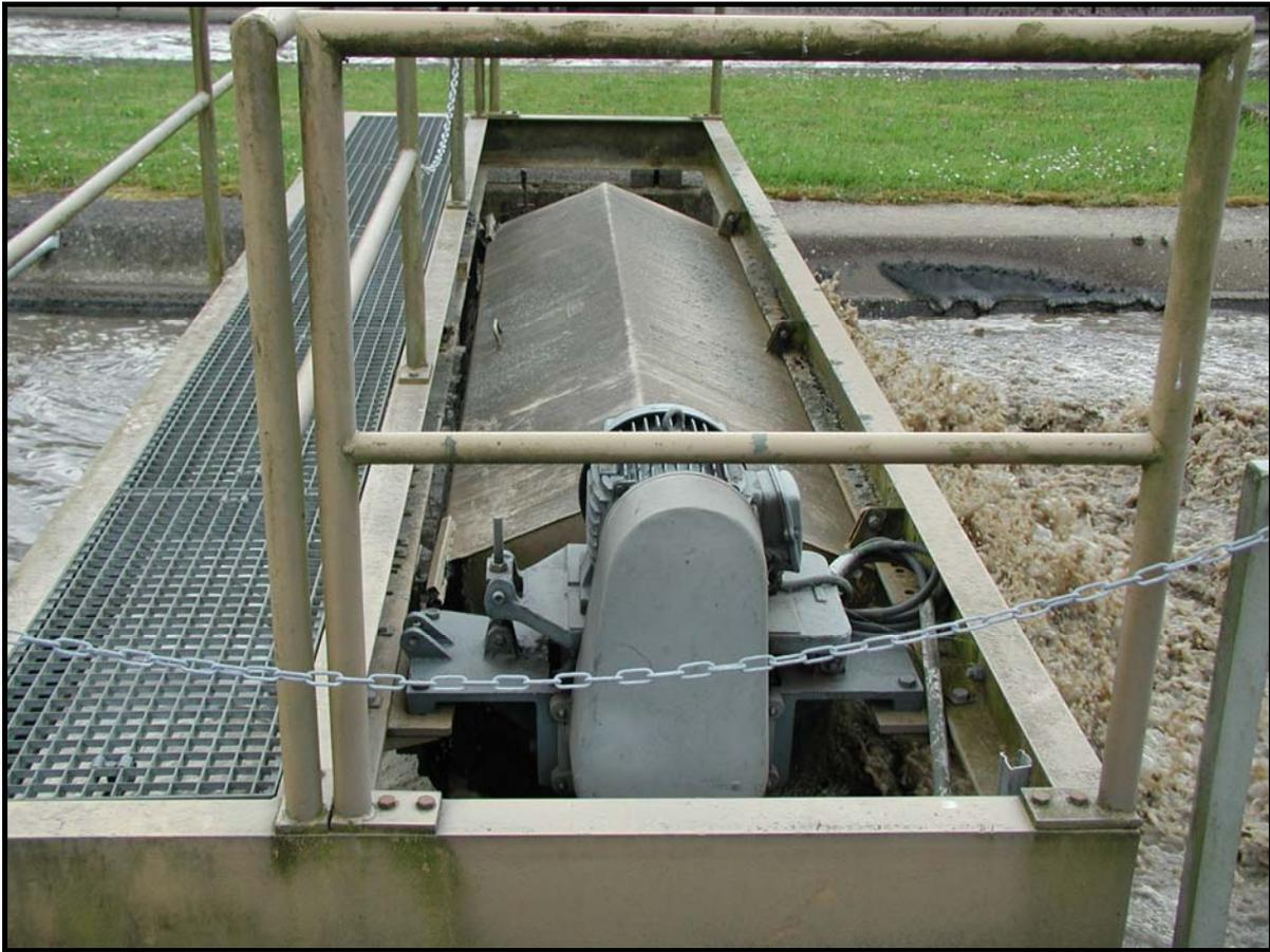
Système d'aération par brosses rotatives des bassins d'activation de la station de Clervaux
