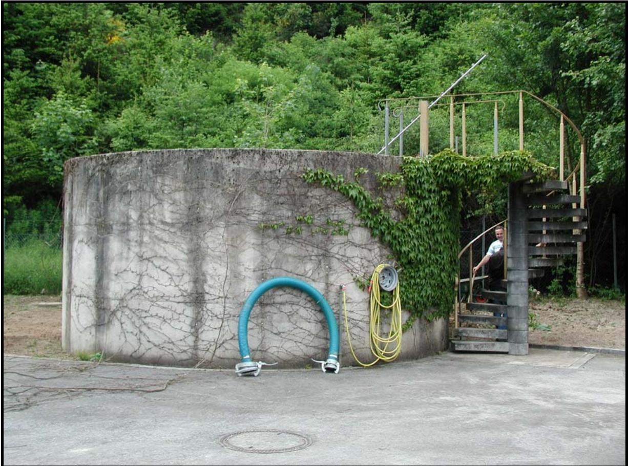
Silo de stockage et d'épaississement des boues épuratoires de la station de Clervaux
