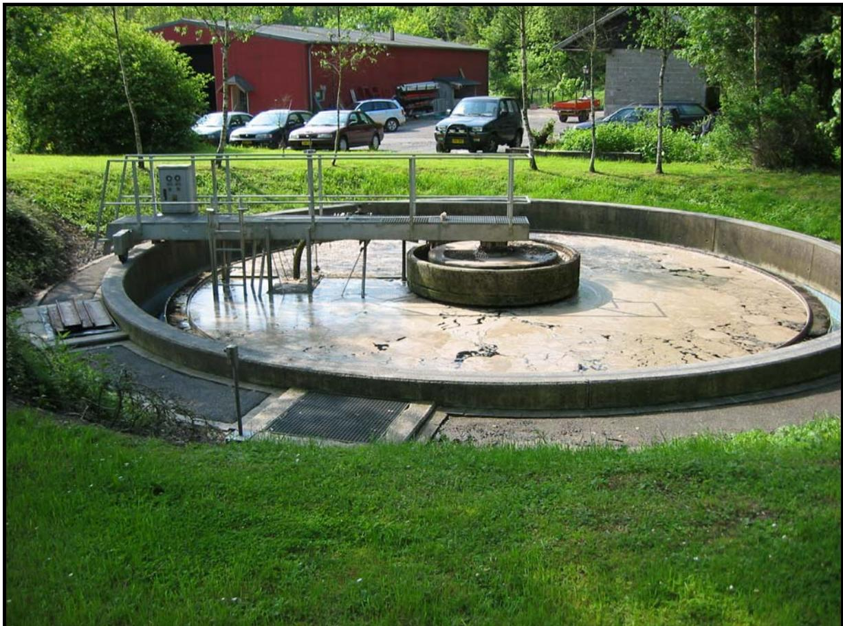
Clarificateur de décantation secondaire avec pont-racleur de la station de Clervaux
