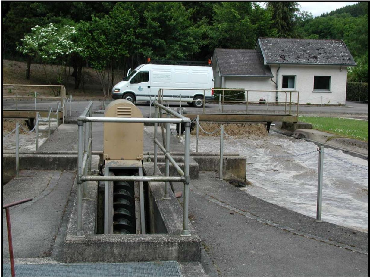
Station de recirculation des boues activées par vis *Archimède* de la station de Clervaux
