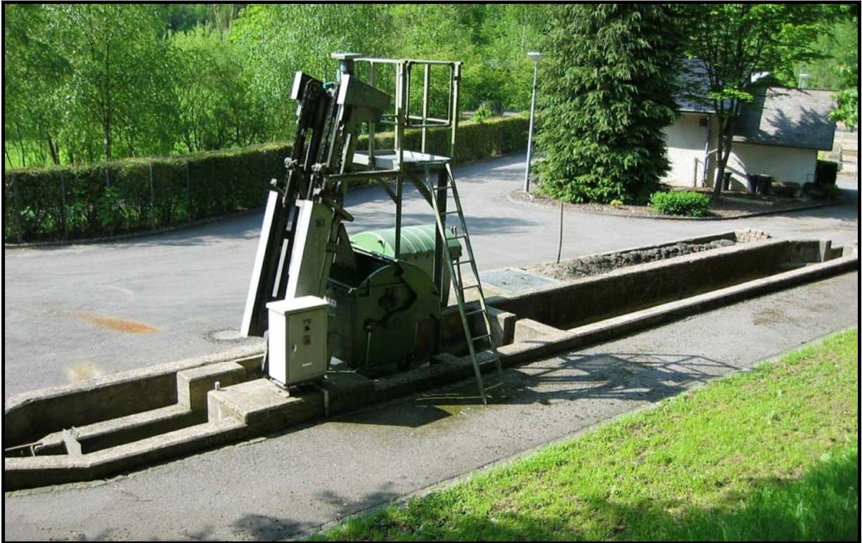
Débitmètre, dégrilleur équicourant automatique, et dessableur du type *Essen* de la station de Clervaux
