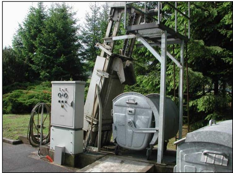
Système de dégrillage automatique écuicourant de la station de Medernach
