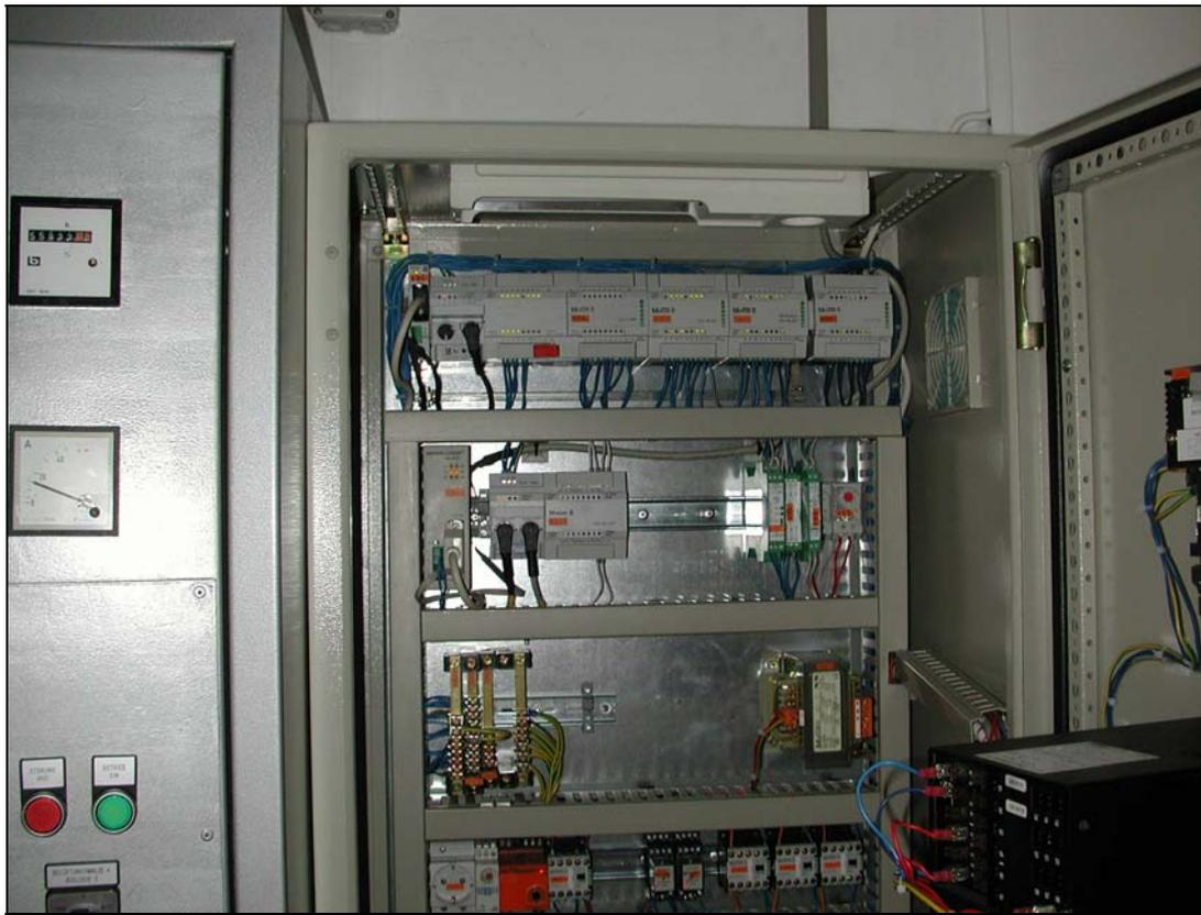
Tableau avec l'automate de commande et de télésurveillance de la station de Medernach
