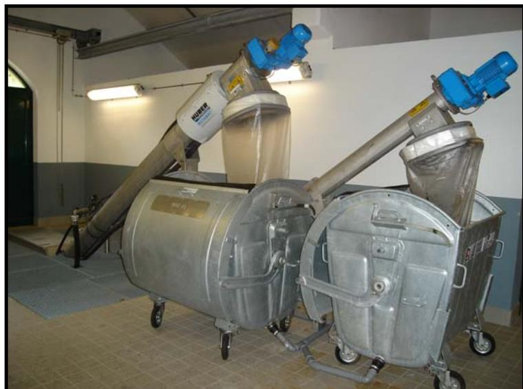
Kombianlage Rechen-, Sand- und Fettfang Kläranlage Welscheid
