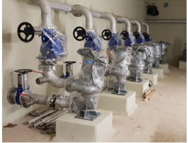
Photo : Pompes de soutirage des boues montées en cave du bâtiment technique
