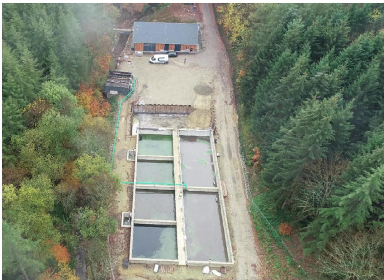
Photo: Nouvelle voie de traitement biologique en eau et au fond bâtiment technique de la station d'épuration de Consdorf
