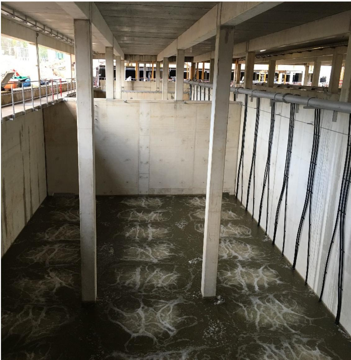
Photo: Chantier Bleesbruck Phase II + III – Essai d'aération dans la filière biologique - voie 1
