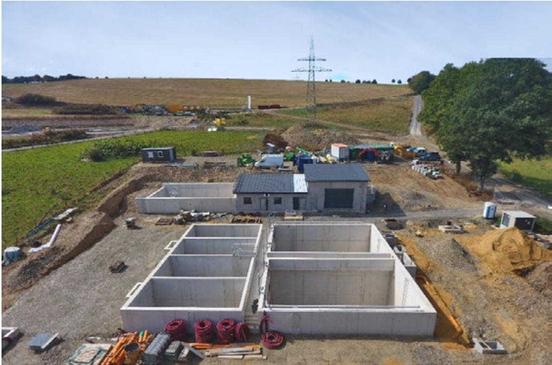
Photo: Station d'épuration à Urspelt – Travaux de gros-cœuvre finalisés et électromécanique en cours de montage
