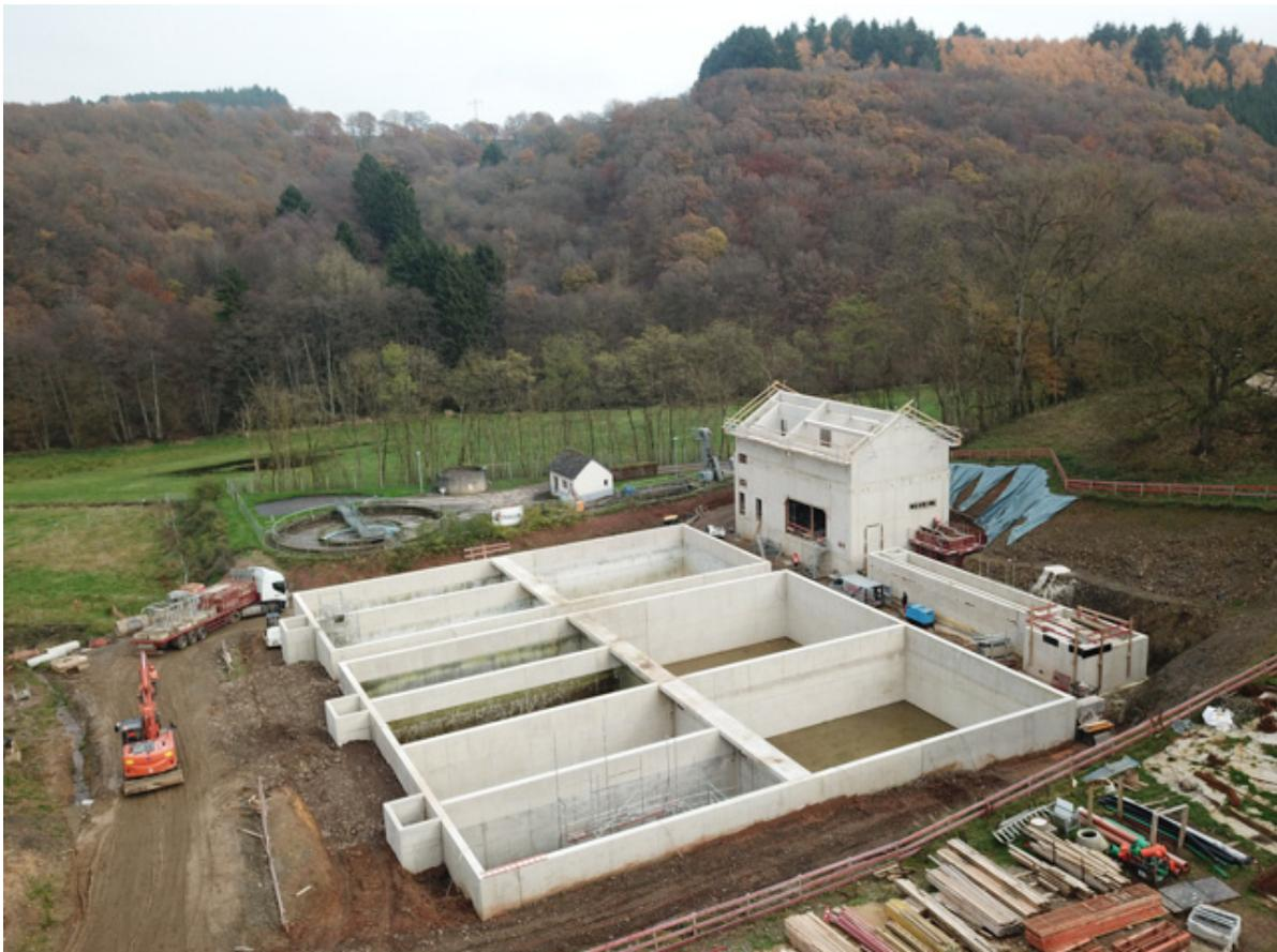
Photo: Chantier de la future station d'épuration à Niederfeulen (9.000 EH)
