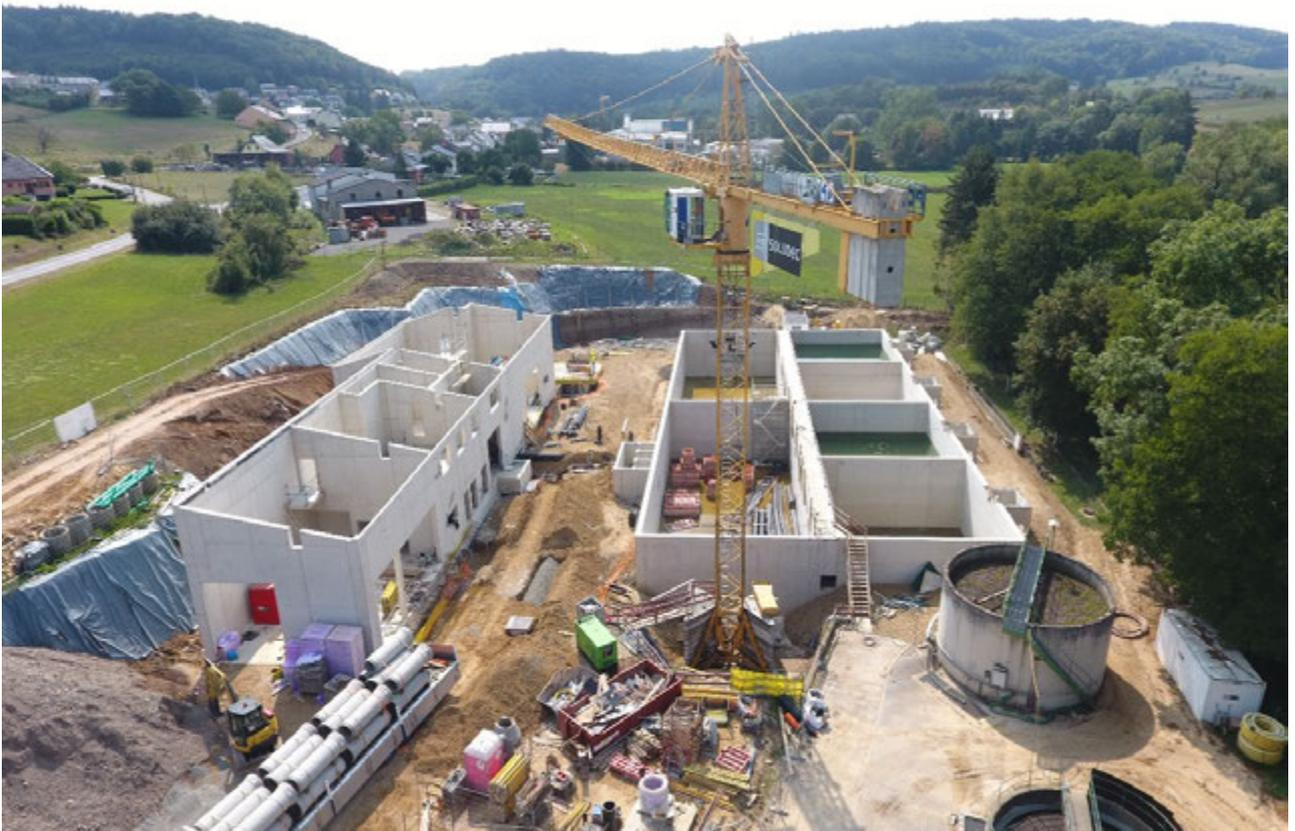
Photo: Travaux de génie-civil en cours de réalisation à la station d'épuration de Medernach
