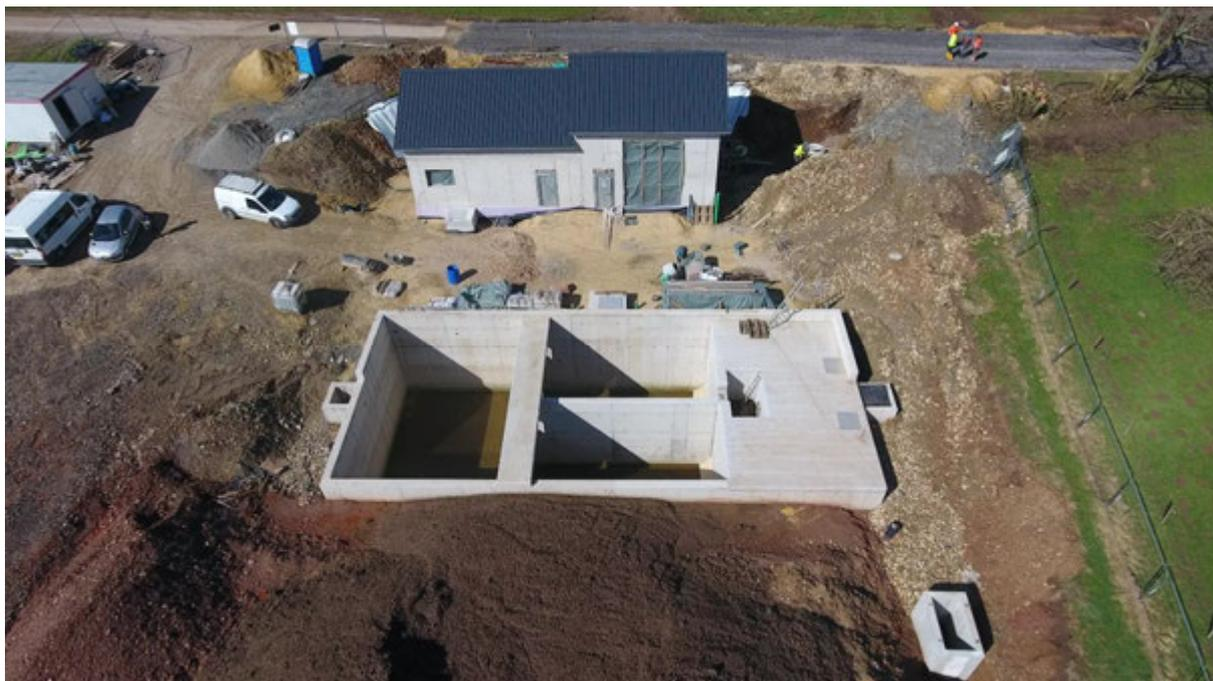
Photo: Travaux de génie civil au niveau de la voie de traitement biologique et du bâtiment technique à Buschrodt
