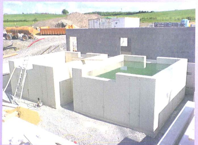
*Stahlbetonbecken für Rotationstauchtropfkörper*
