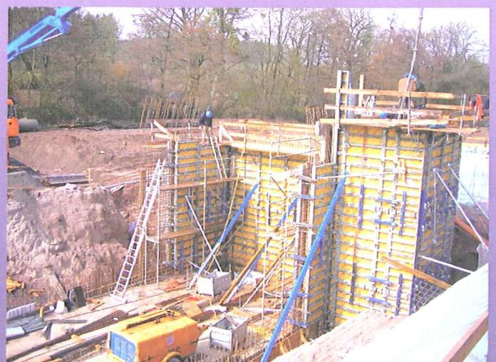
*Schalungs- und Betonierarbeiten der Wände des RÜB*
