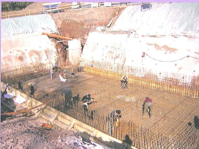
*Bewehrungsarbeiten der Bodenplatte des RÜB*
