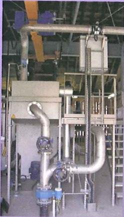
Im Anschluss an das Regenüberlaufbecken gelangt das zugeleitete Mischwasser mittels Druckleitung in die Rechensandfangkompaktanlage. Dieser belüftete Langsandfang mit seitlichem Fettfang in Stahlfertigbauweise führt die erste grobe Reinigung des Abwassers durch.
